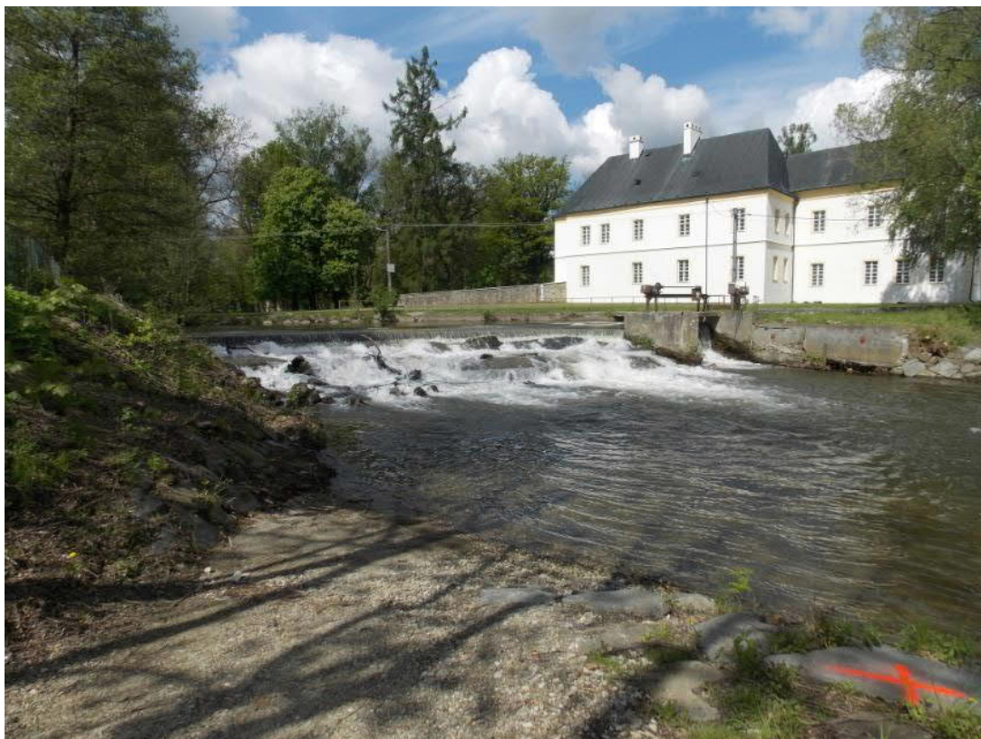
Obr. 1. Stávající, rozpadající se jez a štěrková propust – pohled proti proudu
